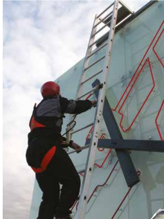
Scala fissa a due montanti di tipo guidato comprendenti una linea di ancoraggio rigida
