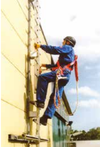
Scala fissa a pioli con un montante dotata di fune anticaduta
