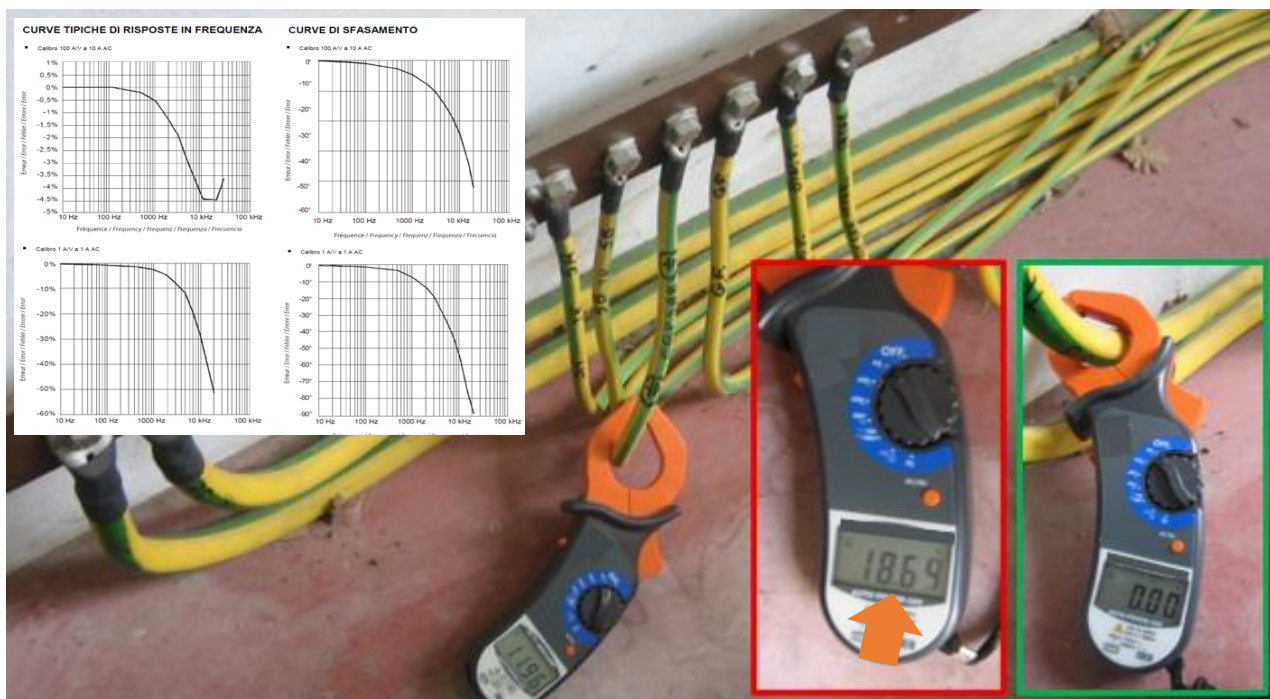
Fig. 7.2.10 – misura delle correnti di dispersione
