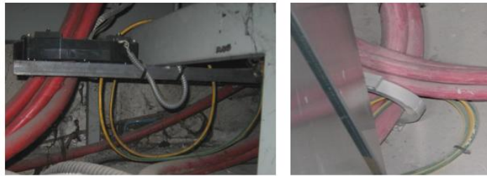
Fig. 7.16.4 – installazione dei trasformatori toroidali
