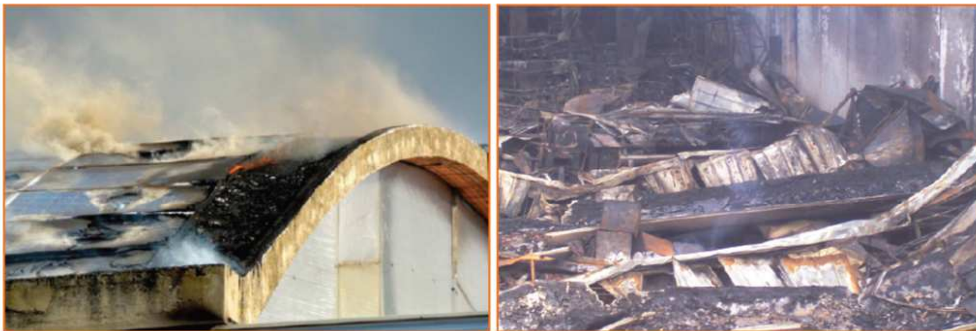
Fig. 9 - Propagazione dell'incendio dai moduli fotovoltaici all'interno dell'edificio.
