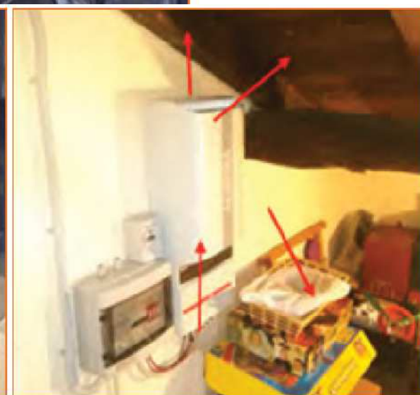
Fig. 15 - Installazione da evitare: materiali facilmente infiammabili posizionati vicino agli inverter.
