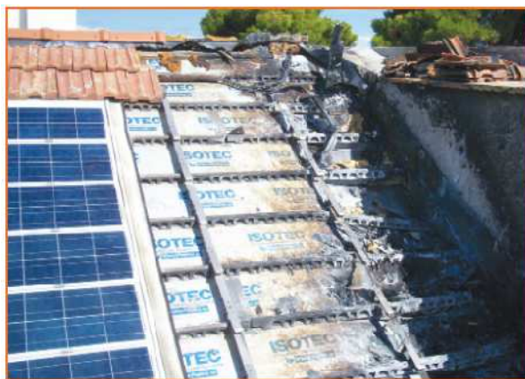
Fig. 2 - Incendio di un impianto fotovoltaico.
