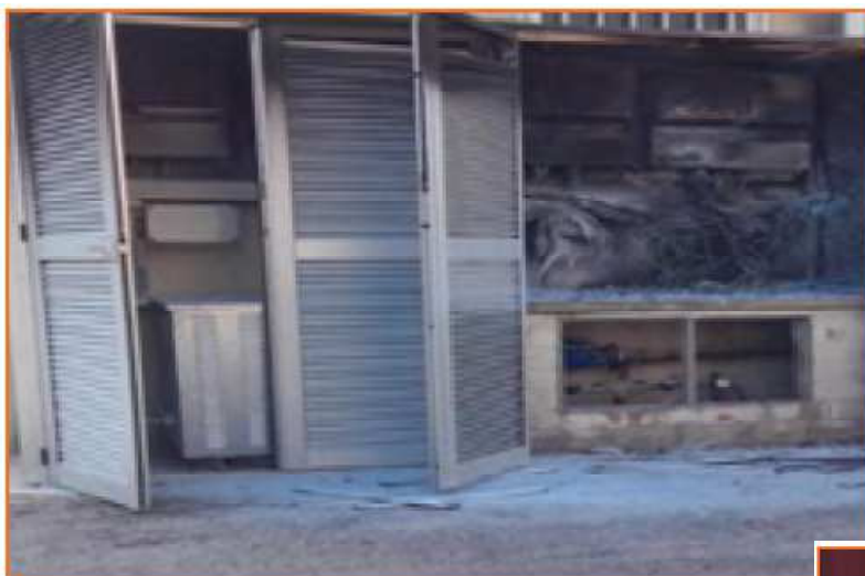
Fig. 14 - Incendio in un locale inverter.
