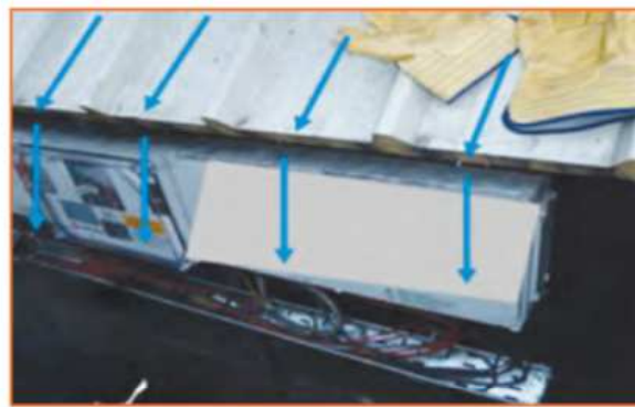
Fig. 12 - Quadro di stringa installato in posizione esposta a grandi quantità d'acqua.
