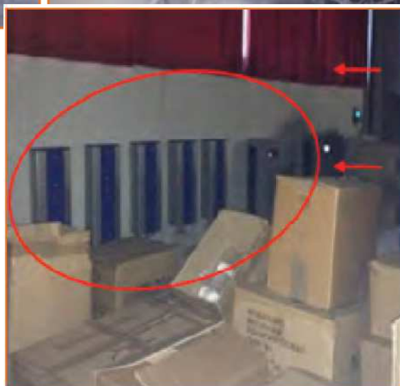
Fig. 15 - Installazione da evitare: materiali facilmente infiammabili posizionati vicino agli inverter.
