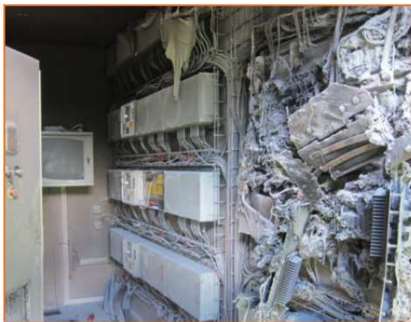
Fig. 4 - Incendio di un impianto fotovoltaico.
