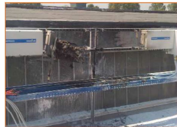
Fig. 3 - Incendio di un impianto fotovoltaico.
