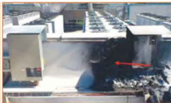
Fig. 12 - Quadro di stringa installato in posizione esposta a grandi quantità d'acqua.
