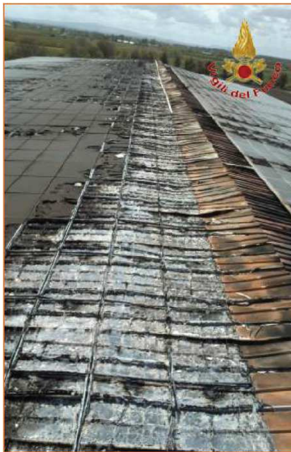
Fig. 1 - Incendio di un impianto fotovoltaico.
